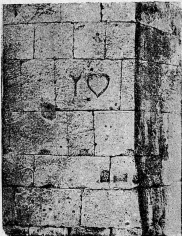
19. Тамга на блоке кладки древней оборонительной стены около арки.
