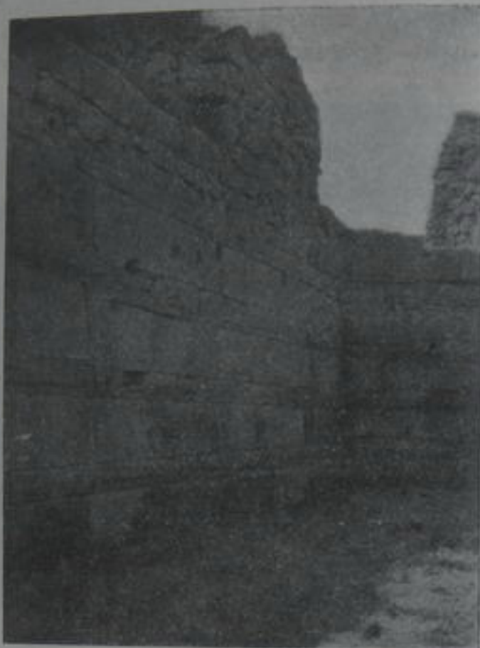
Оборонительная стѣна. Характеръ кладки трехъ главныхъ эпохъ. Три нижнихъ ряда—кладки греческой эллинистической эпохи, середина—римской эпохи, верхніе ряды—византийской. (Фот. Херсон. музея).
