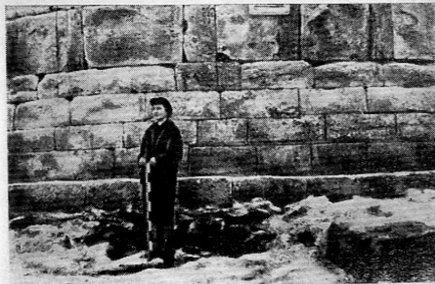
Облицовка третьего строительного периода башни: поколь и четыре нижних ряда кладки.
