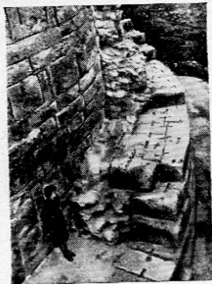
Пятый строительный период башни. Слева — облицовка четвертого периода.
