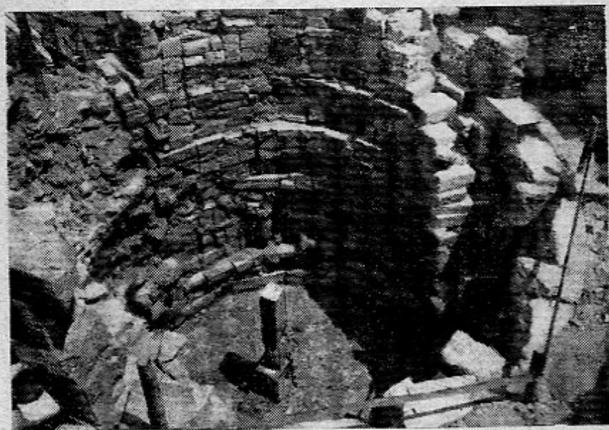
Внутренняя кладка облицовки (ядра), сложенная из фрагментов и архитектурных деталей IV—III вв. до н. э. В центре — основание подсобного столба, от которого промерялся радиус башни при ее сооружении.
